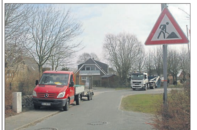
An der Straße Norderwurth will die Schleswig-Holstein Netz AG morgen eine Ortswechselstation auswechseln.
